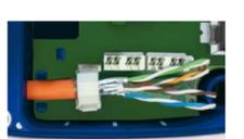
Legen Sie die 8 Einzeladern mit einem LSA-Werkzeug entsprechend dem verwendeten Schema (TIA 568A bzw. 568B) auf.
