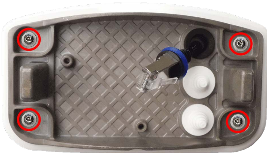
Abb. 23: Anbringen der Montageplatte an der Wand
